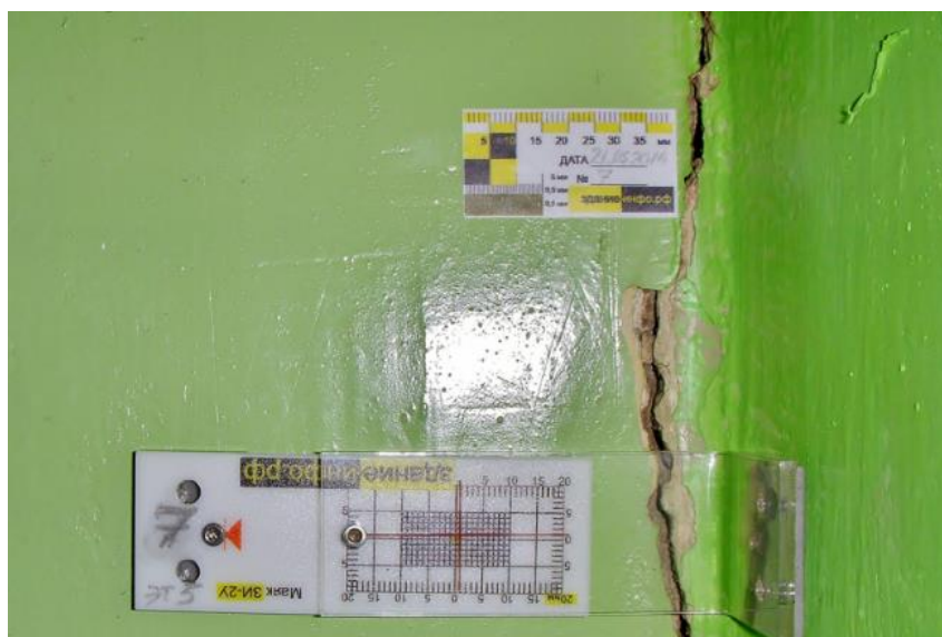
Пример 1. Установка Маяка углового пластинчатого типа
