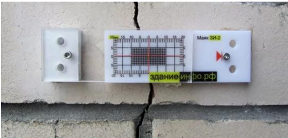
Пример 4. Маяк пластинчатого типа
